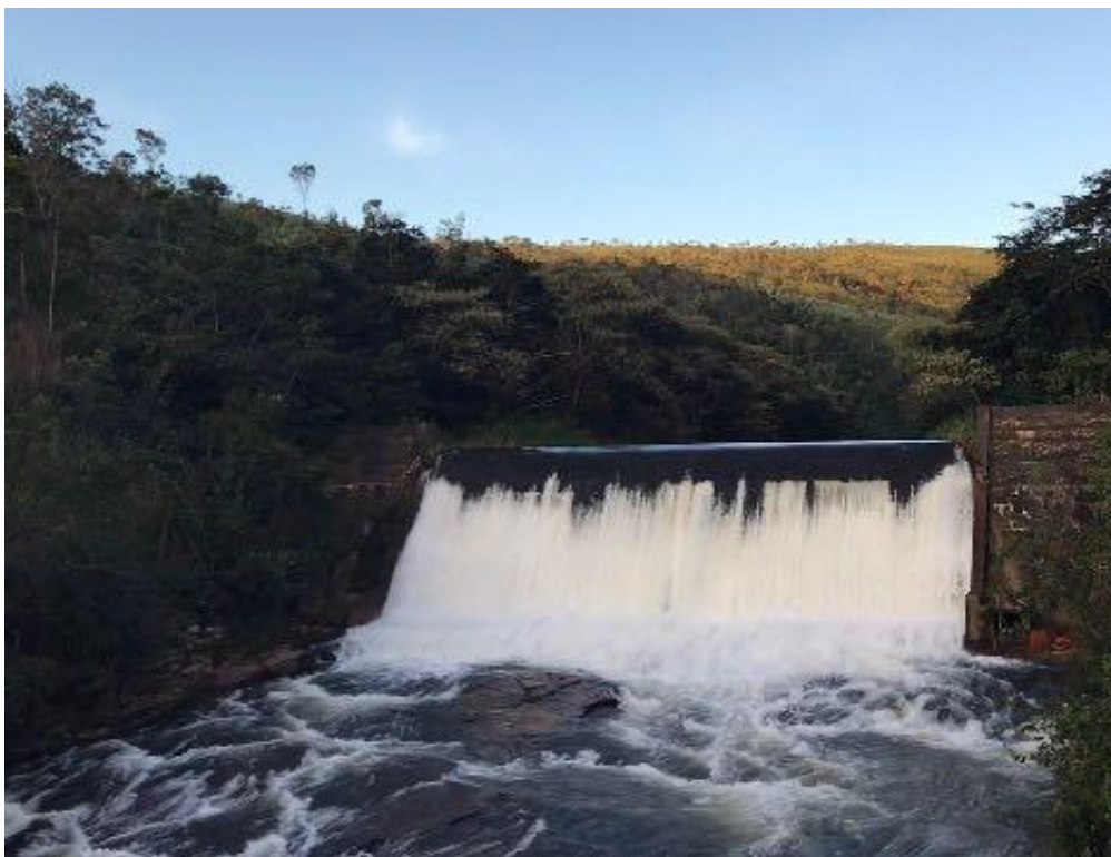
Foto 5. Barragem da usina da cidade da Fraternidade (Março 2018).
